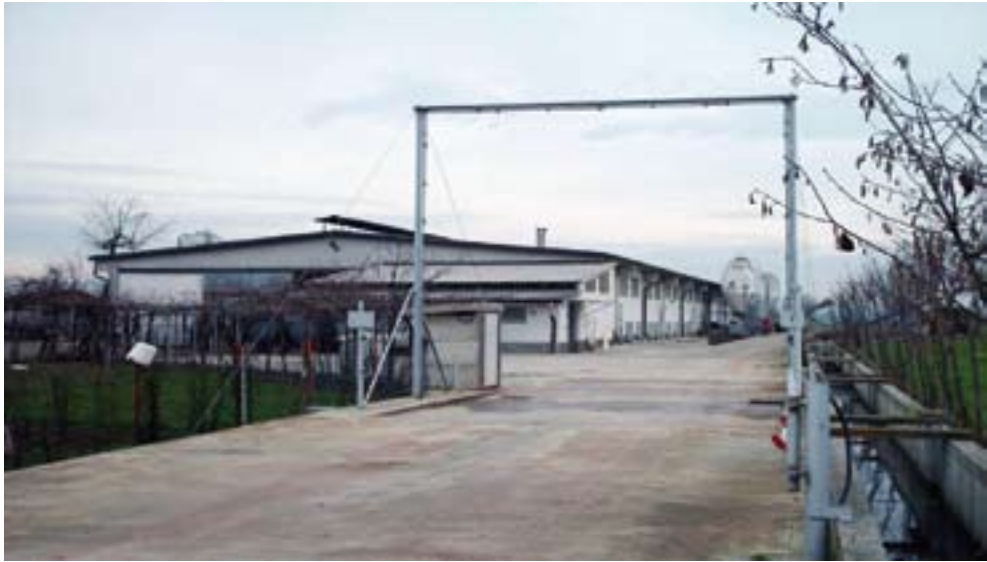
Figura 4. Arco per la disinfezione di automezzi in entrata all'allevamento
