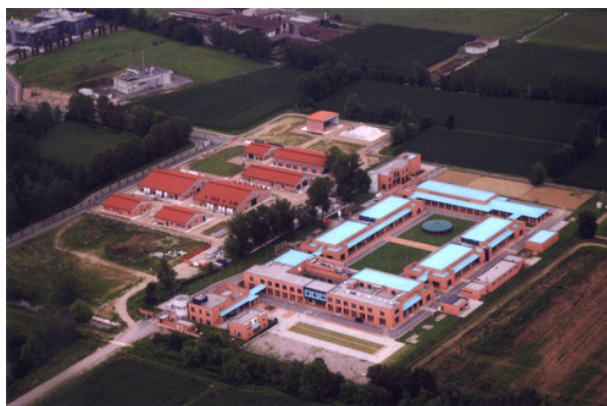
Veduta aerea del Polo di Lodi
